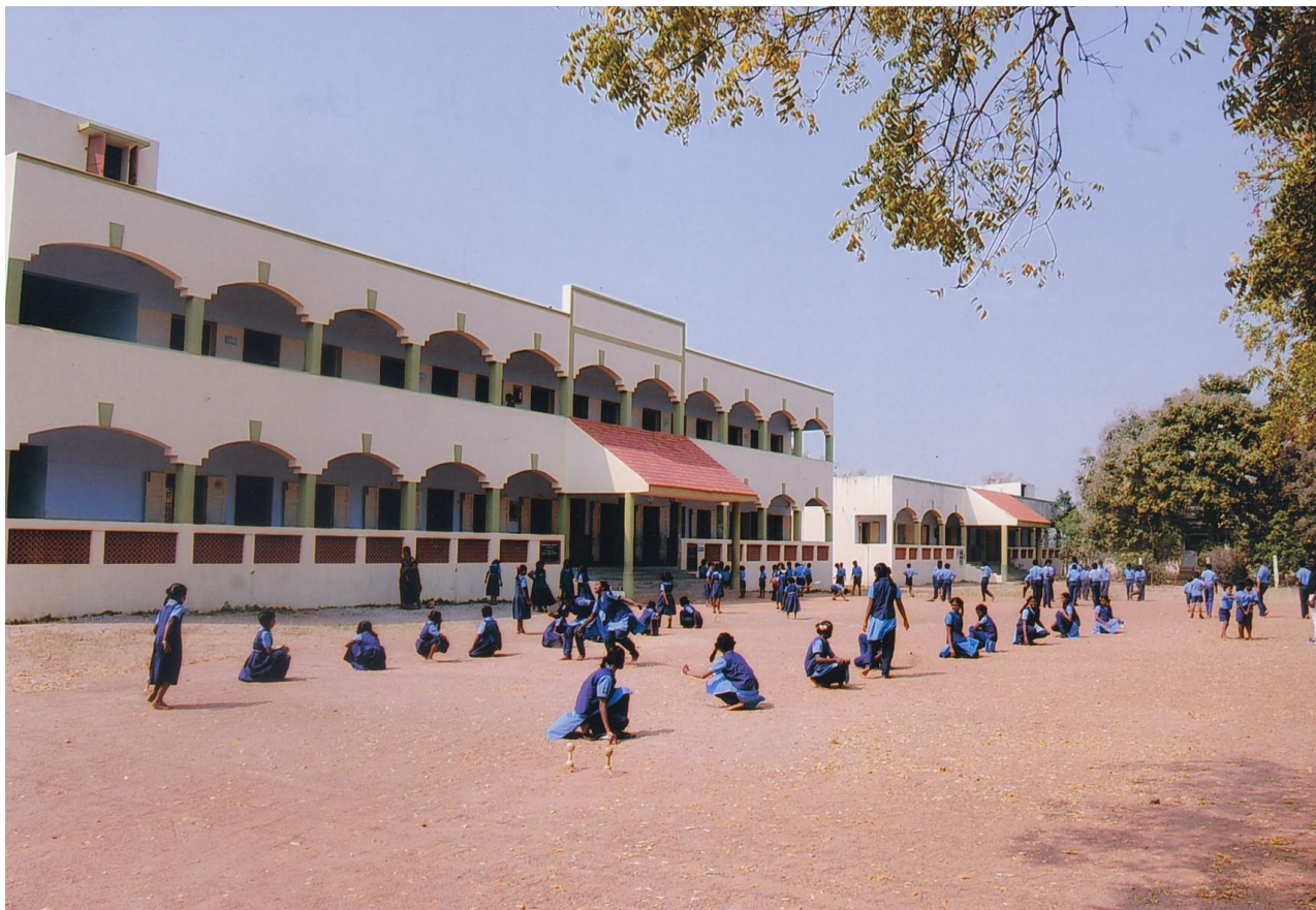
Campus con sullo sfondo l'edificio da sopraelevare
