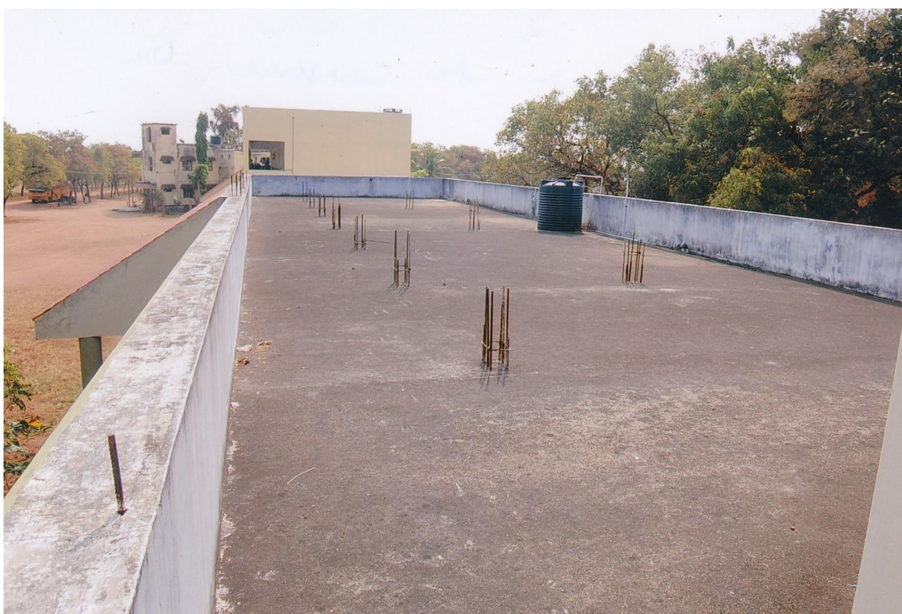
Tetto dell'edificio da sopraelevare; sullo sfondo l'edificio gemello a due piani e la vecchia scuola a tre piani
